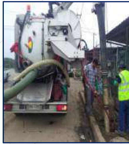
Limpieza de Alcantarillas Externas de los Mercados
