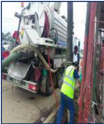
Limpieza de Alcantarillas Externas de los Mercados
